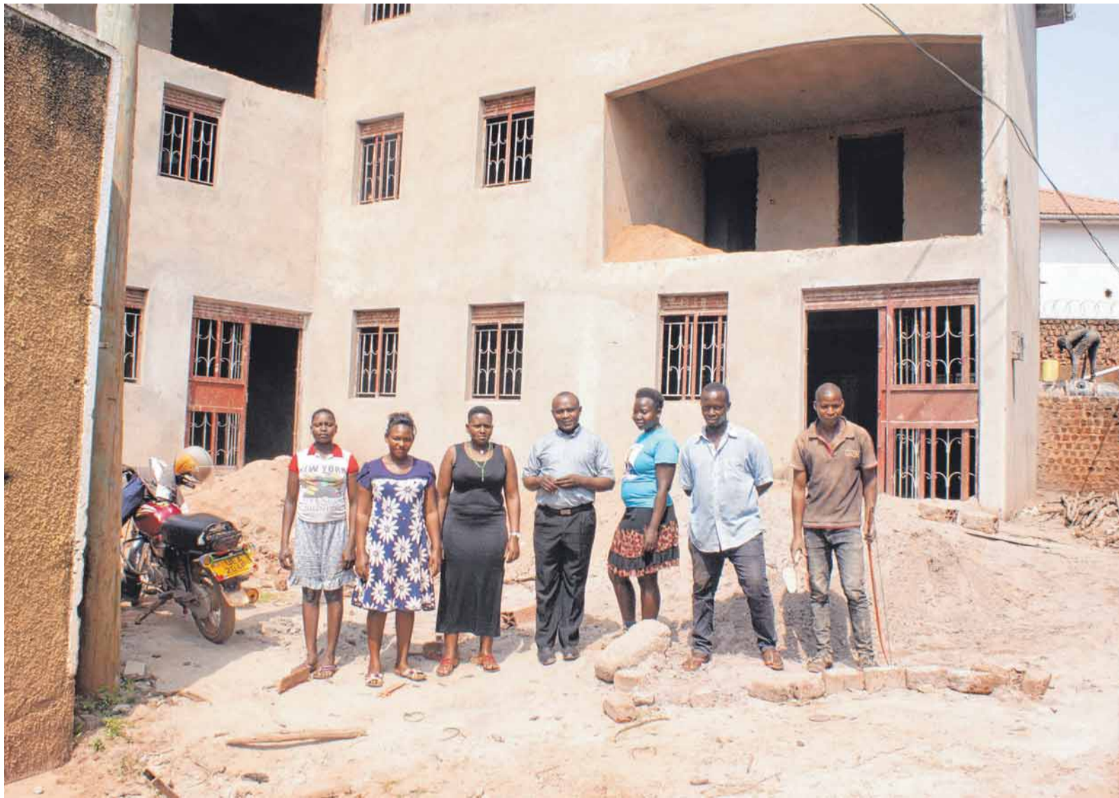
In Nalukolongo, nur zehn Kilometer von der Hauptstadt Kampala entfernt, soll ein Ausbildungszentrum mit Berufsschule realisiert werden.
