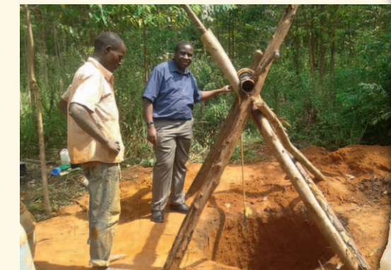
Brunnen im Bau
